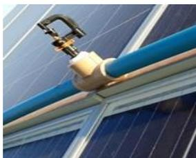
**Figura 2.** Sistema de refrigeração por aspersão de água
