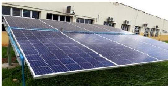
**Figura 1.** Sistema de energia fotovoltaica com refrigeração por aspersão de água
